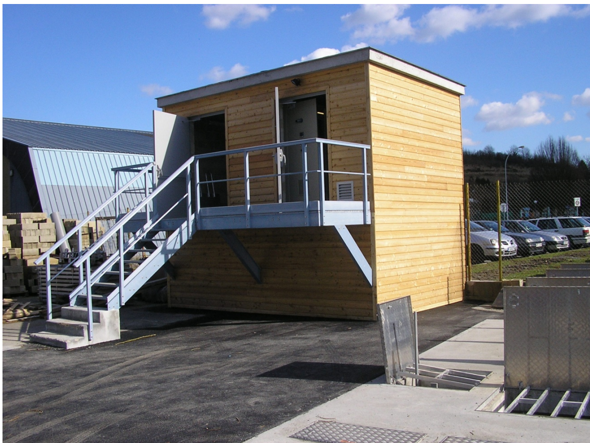
➤ Local technique du poste de crue de la rue du Paradis
