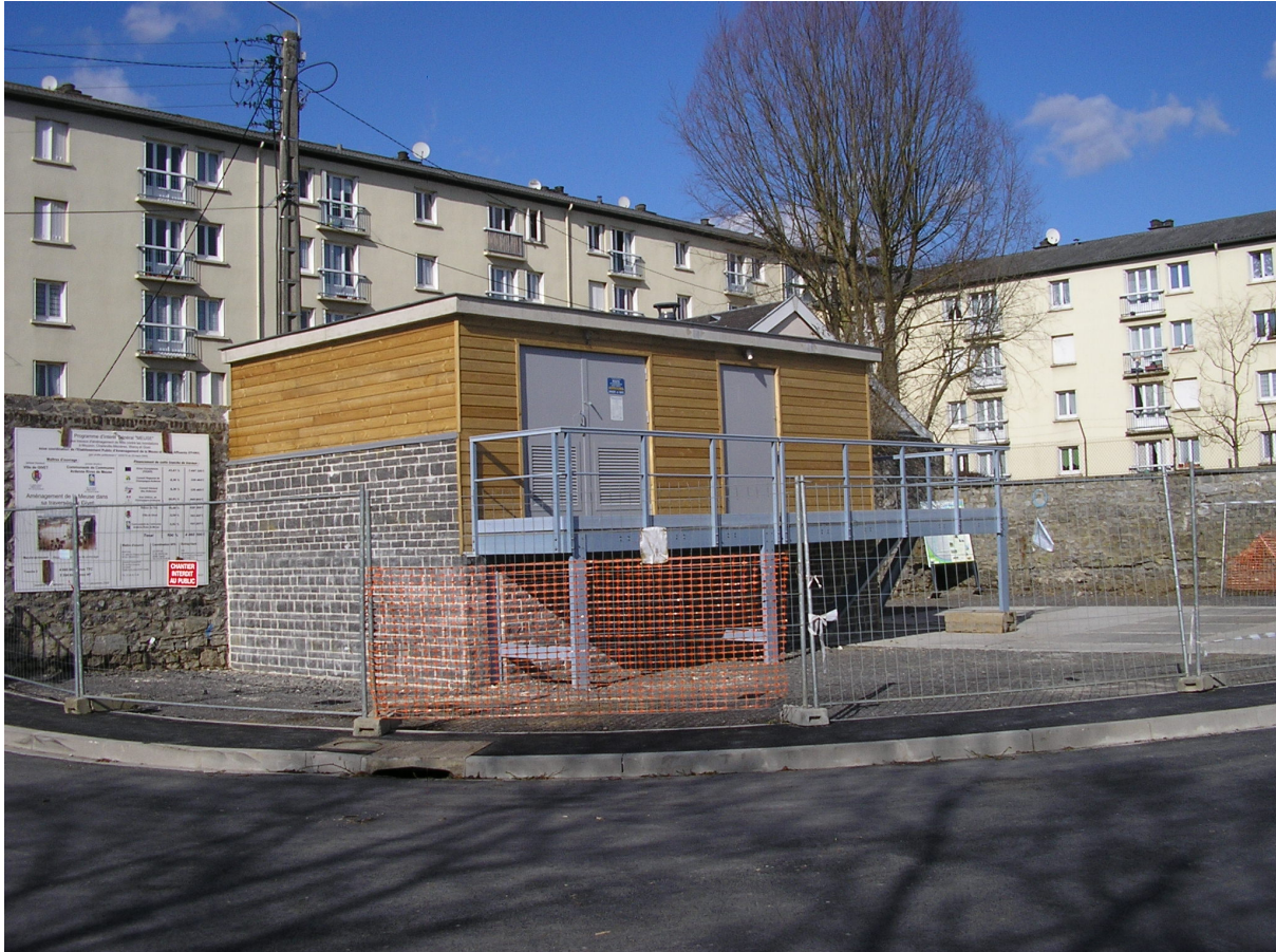
➤ Local technique du poste de crue de la rue de l'Hôpital
