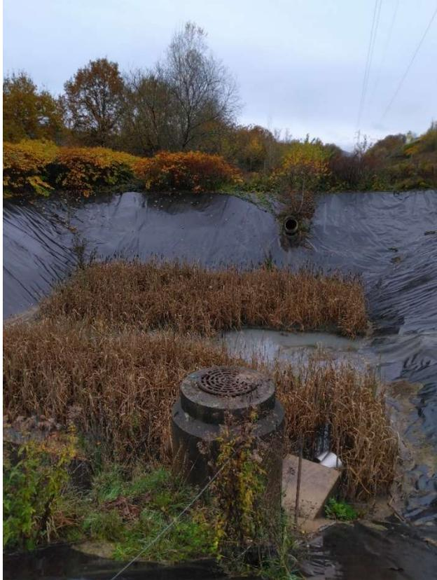
Le fond est enlisé (perte de volume) et de la végétation s'est développée. La bâche est en mauvais état et trouée par endroits à cause de la pousse d'arbrisseaux. Aucune rampe ou escalier d'accès ne permet d'accéder au fond pour réaliser un entretien régulier, surtout avec des moyens mécaniques.
