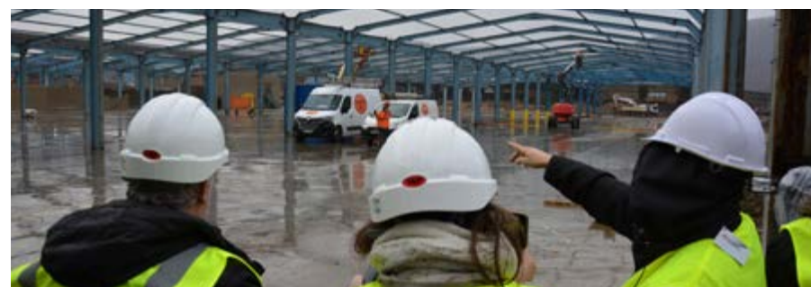
L'avancée des travaux de CIBOX
