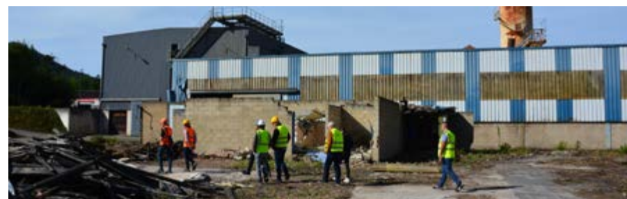
L'avancée des travaux du site Oxame
